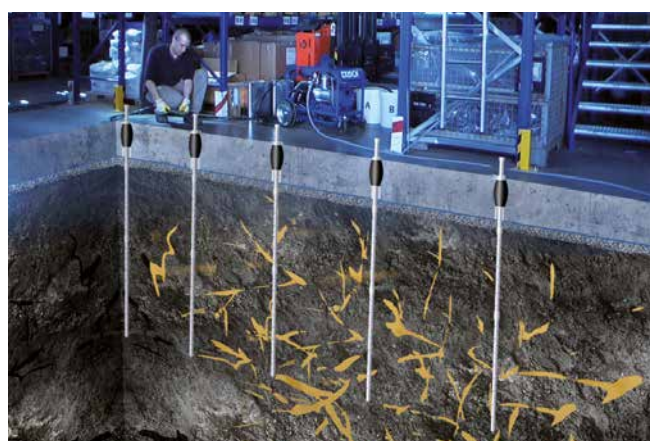
Ausbreitung Injektionsmittel, Arbeiten im freien Gelände und unter bestehenden Bodenplatten
