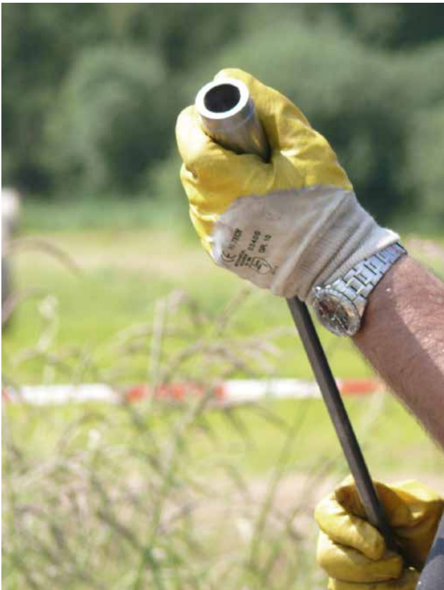
Montage der Rammverpresslanzen
