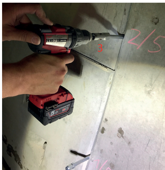
Bild 4: Eindrehen von Injektionsbohrnadel und Injektionsrohr mithilfe eines Akkuschaubers und eines Einbohraufsatzes (3)
