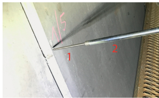
Bild 3: Injektionsbohrnadel (1) und Injektionsrohr (2) als Werkzeuge für die gezielte Fugennachdichtung
