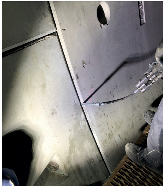
Bild 6: Injizieren der Tübbingfuge
