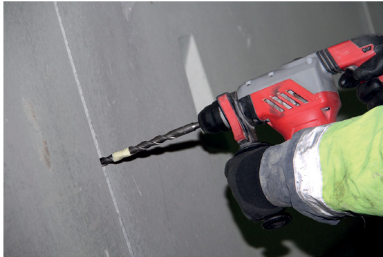
Bild 2: Aufbohren einer Tübbingfuge mit einem Betonbohrer mit 18 mm Durchmesser
