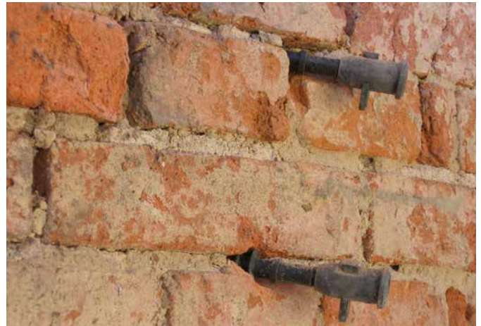
Einsatz von Lamellenschlagpacker mit Verschlussstück | Use of lamella drive-in packer with shut-off piece
