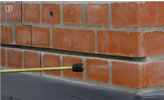
Fuge vornässen | Wet the joint / slot
