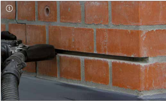
Fuge mit AS200X Stein- und Fugensäge aussägen Cut the joint / slot by using the AS200X Brick and mortar saw
