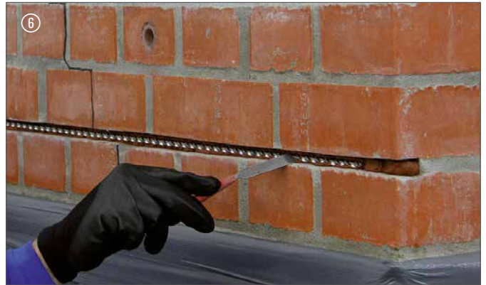
DESOI Spiralanker in den Spiralankermörtel drücken | Embed the DESOI Spiral Anchor Mortar
