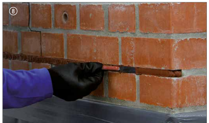
DESOI Spiralankermörtel glattstreichen | Flatten out the DESOI Spiral Anchor Mortar
