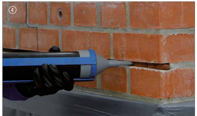
Erste Lage DESOI Spiralankermörtel einbringen | Insert first layer of DESOI Spiral Anchor Mortar
